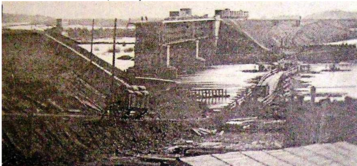
Слева аварийный мост, справа временный наплавной мост (1867 г.) (фото из газеты «ЗТ», 18.11.1994)
