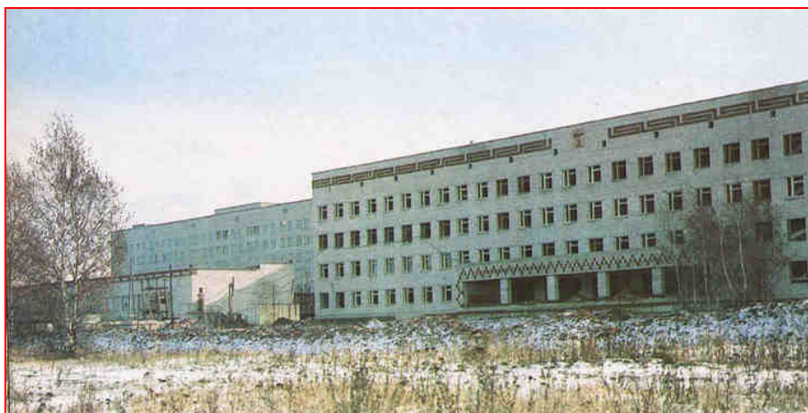
МСЧ ЗиДа строится
