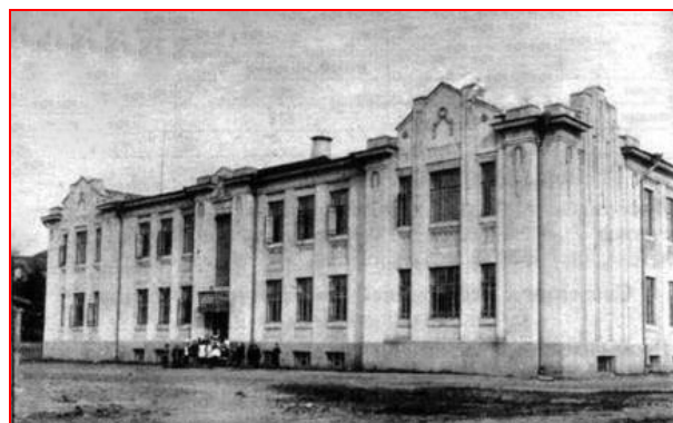
новое здание реального училища (ул. Н.С. Абельмана, 15) (1910-1918)
