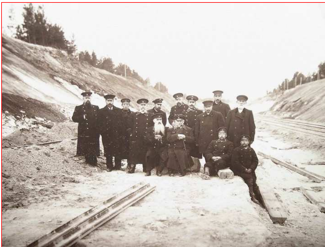
Группа инженеров путей сообщения на строящейся Муромской магистрали
