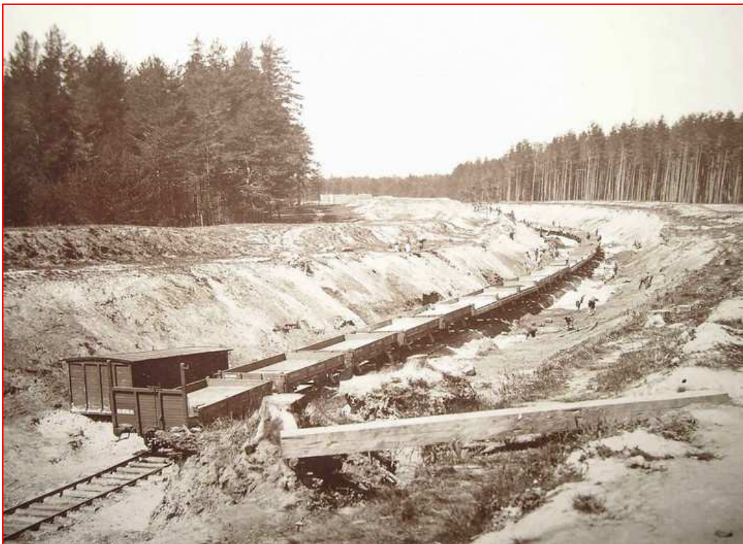
Процесс строительства Муромской железной дороги
