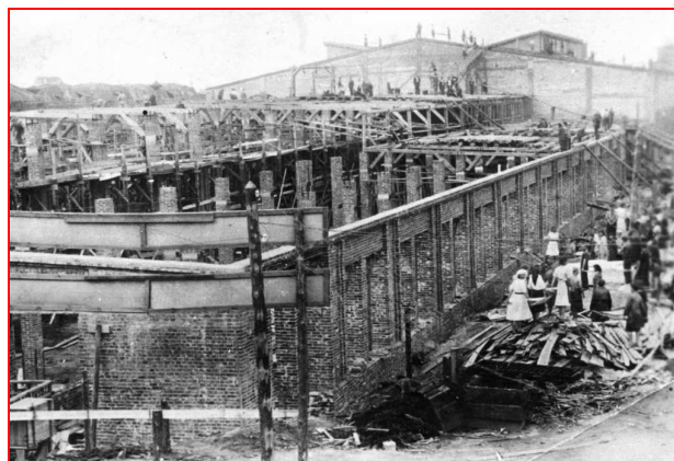
Строительство корпуса на ЗИК (1943 г.) (фото из архива Г.В.Жуковой, из ДП)
