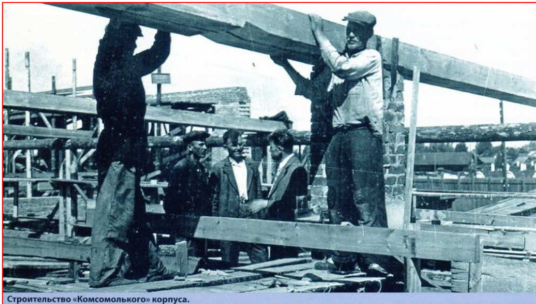
Строительство «Комсомольского» корпуса.
